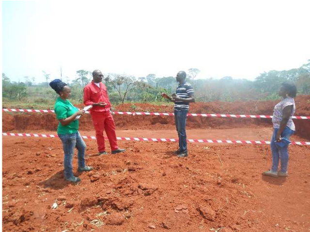
Réception nouvelle fosse à déchets
